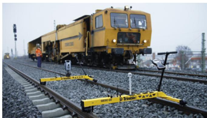
LE BOURRAGE EST ESSENTIEL POUR L'ENTRETIEN DES VOIES FERRÉES AFIN DE GARANTIR LA QUALITÉ DE LA VOIE ET LA STABILITÉ DU BALLAST. TRIMBLE GEDO OFFRE UNE SOLUTION INTÉGRÉE DE MESURES ET DE CONTRÔLE DE QUALITÉ AUX BOURREUSES ET AUX OPÉRATIONS DE COMPACTAGE.
